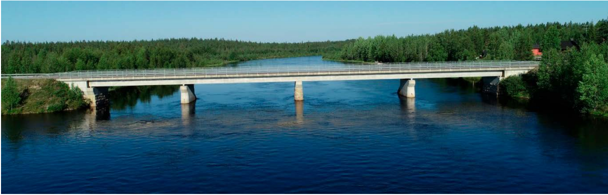
Bild 3 Sammanhängande plattbro av armerad betong med fyra öppningar.
