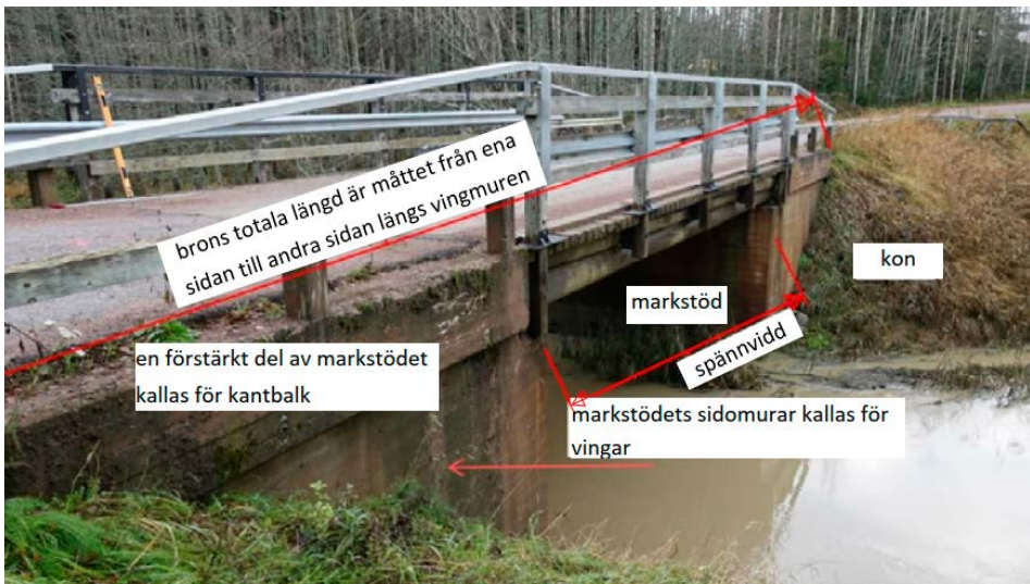
Bild 7 Mått i längdriktningen på en balkbro med markstöd av betong och namn på delar (på bilden en balkbro av stål med trädäck och har rundstocks balkar på sidorna).
