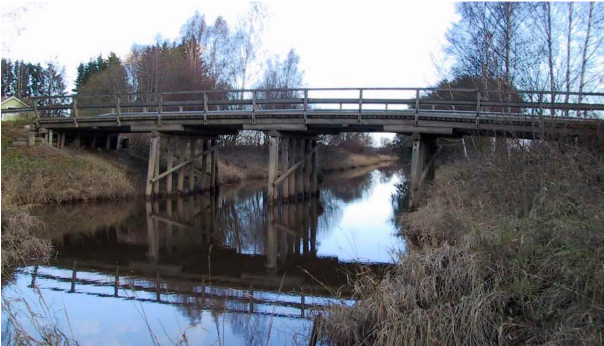
Bild 4 Rundstocksbro med fyra öppningar. Bron har grundlagts direkt på träpålar.
