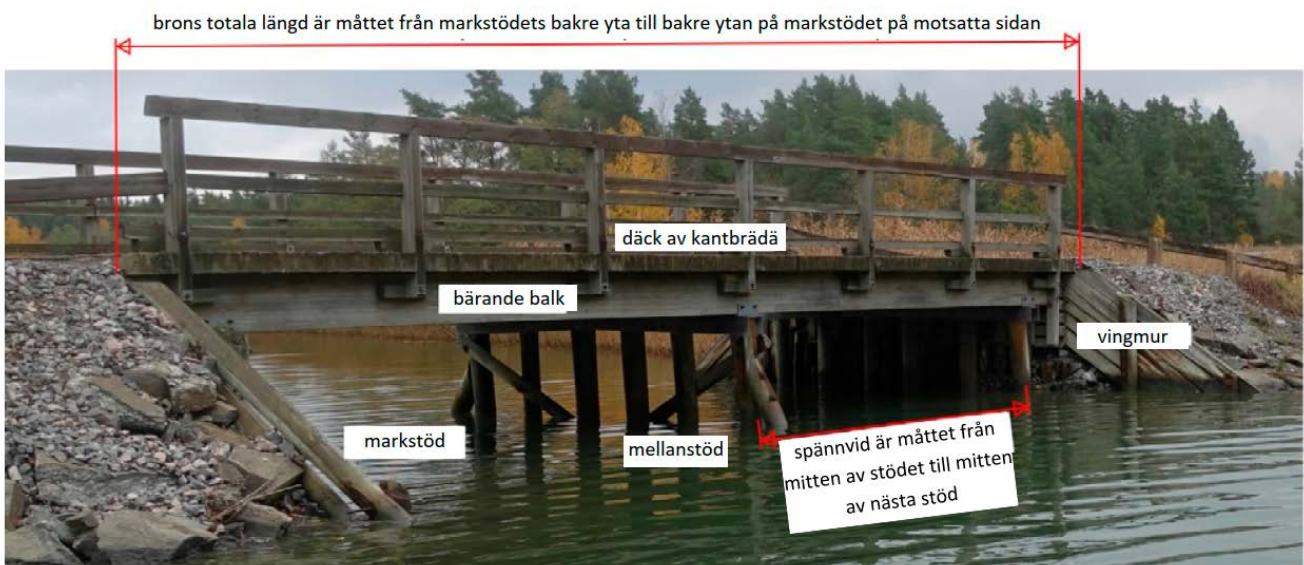
Bild 5 Mått i längdriktningen på en träbro och namn på delar (på bilden en sammanhängande limmad balkbro med två öppningar).
