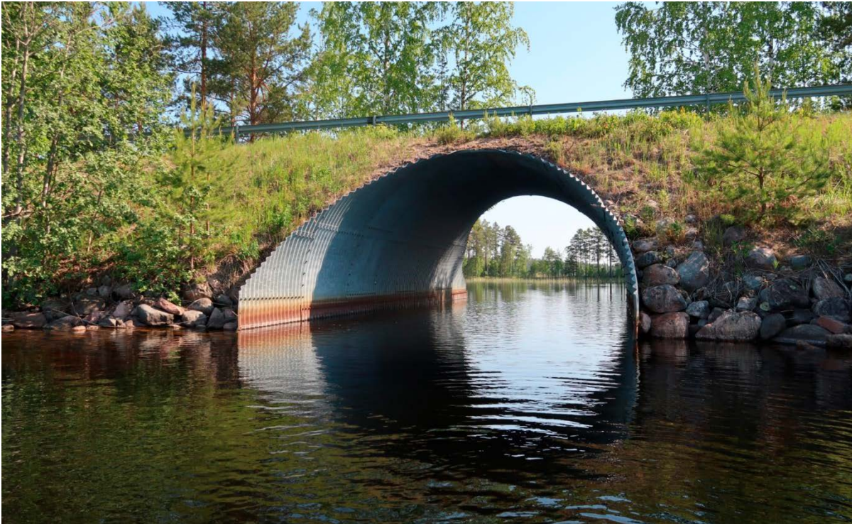
Bild 2 Rörbro av stål.
