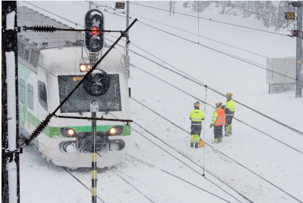
Kuva 5. Työryhmä lumitöissä liikennepaikalla (Lähde: Väylävirasto)
