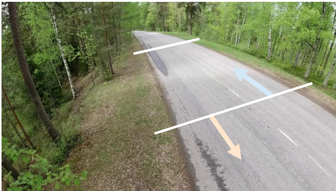
Kuva. Järjestely ennen-tilanteessa (kuvakulma ajosuunnassa länteen).
