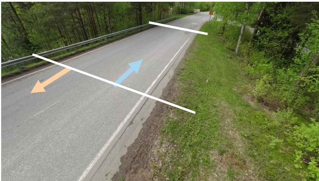
Kuva. Järjestely ennen-tilanteessa (kuvakulma ajosuunnassa länteen).
