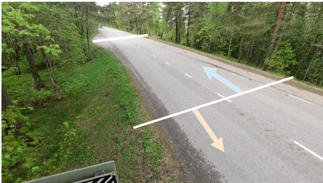
Kuva. Järjestely ennen-tilanteessa (kuvakulma ajosuunnassa länteen).
