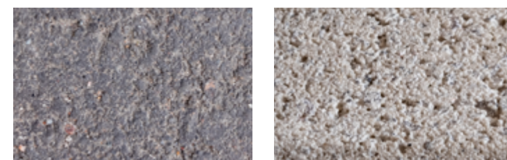
uusi asfaltti valkoinen betonikivi
