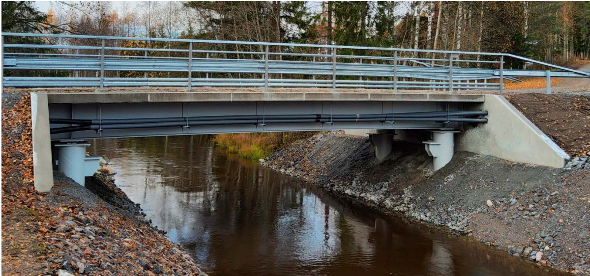
Kuva 1 Teräksinen palkkisilta, betonikantinen, liittorakenteinen. Silta on perustettu teräksisten suurpaalujen päälle. Sillassa on betoniset päätymuurit ja kansielementit. Sillan palkin kylkeen on kiinnitetty maakaapelit. Sillassa on tyyppihyväksytyt teräskaiteet.
