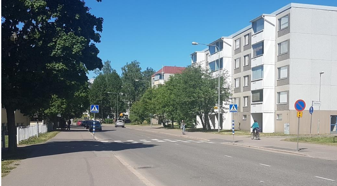
Mannilantien suojatielle asennettiin välkky-valot sekä nopeusnäyttö.
