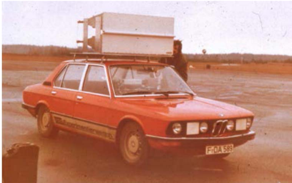
Kuva 2. 10 GHz ajoneuvotutkan prototyyppi 70-luvun alkupuolelta (Meinel, 2014).
