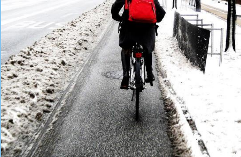
Pyöräteiden oikea-aikainen lumenpoisto esim. harjasuolaamalla johtaa hyvään pyöräiltävyyteen. Kööpenhamina.
