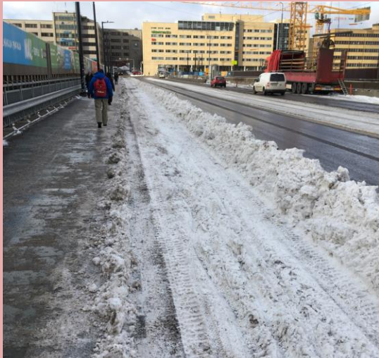
Välikaistan puute johtaa tilanteeseen, jossa ajoradalta pyörätielle aurattu lumi aiheuttaa ongelman. Pasilansilta, Helsinki.
