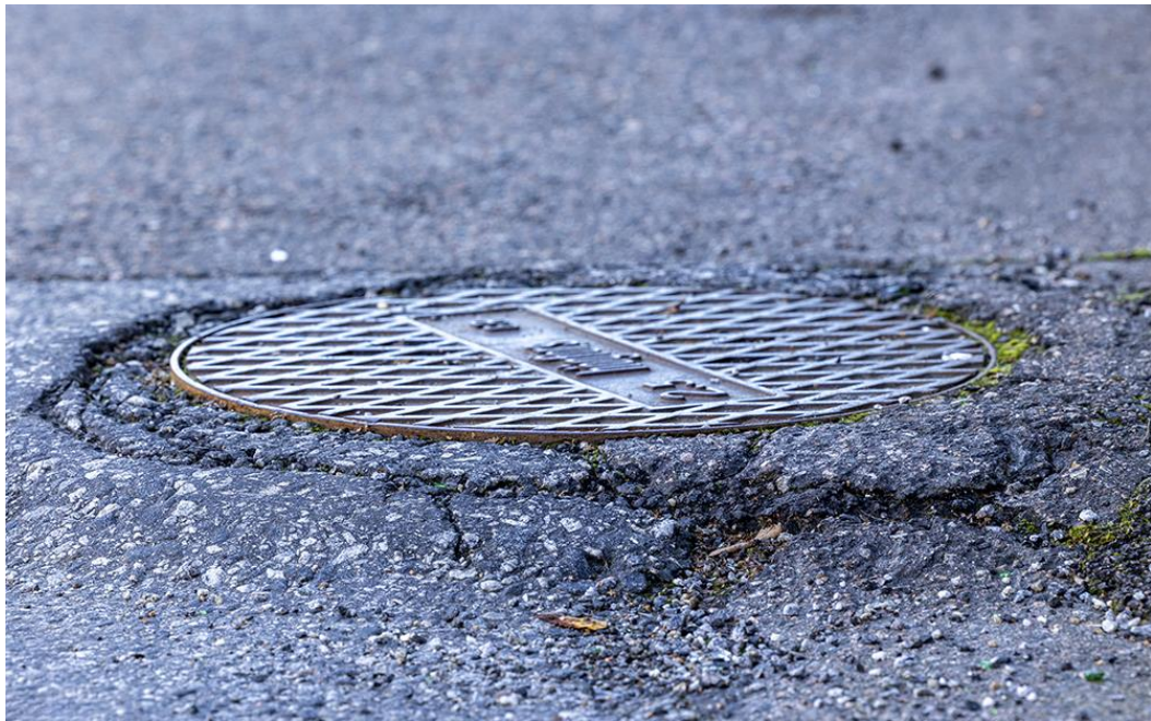
Kuva 14. Koholla oleva kaivonkansi. Kuva: Kuopion kaupunki, Vicente Serra
