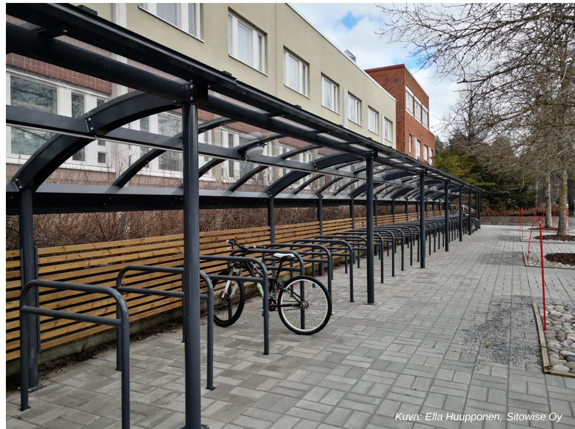
Kuva 25. Laadukas pyöräkatos, jossa on oikealla välimatkalla asennettuja runkokaaritelineitä.
