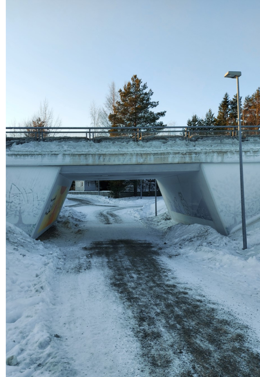
Kuva 1. Alikulut ovat esimerkki muutoskohdasta, johon saattaa helposti kertyä lumivalleja ja jossa reitin kunto voi käyttäjän näkökulmasta muuttua.
