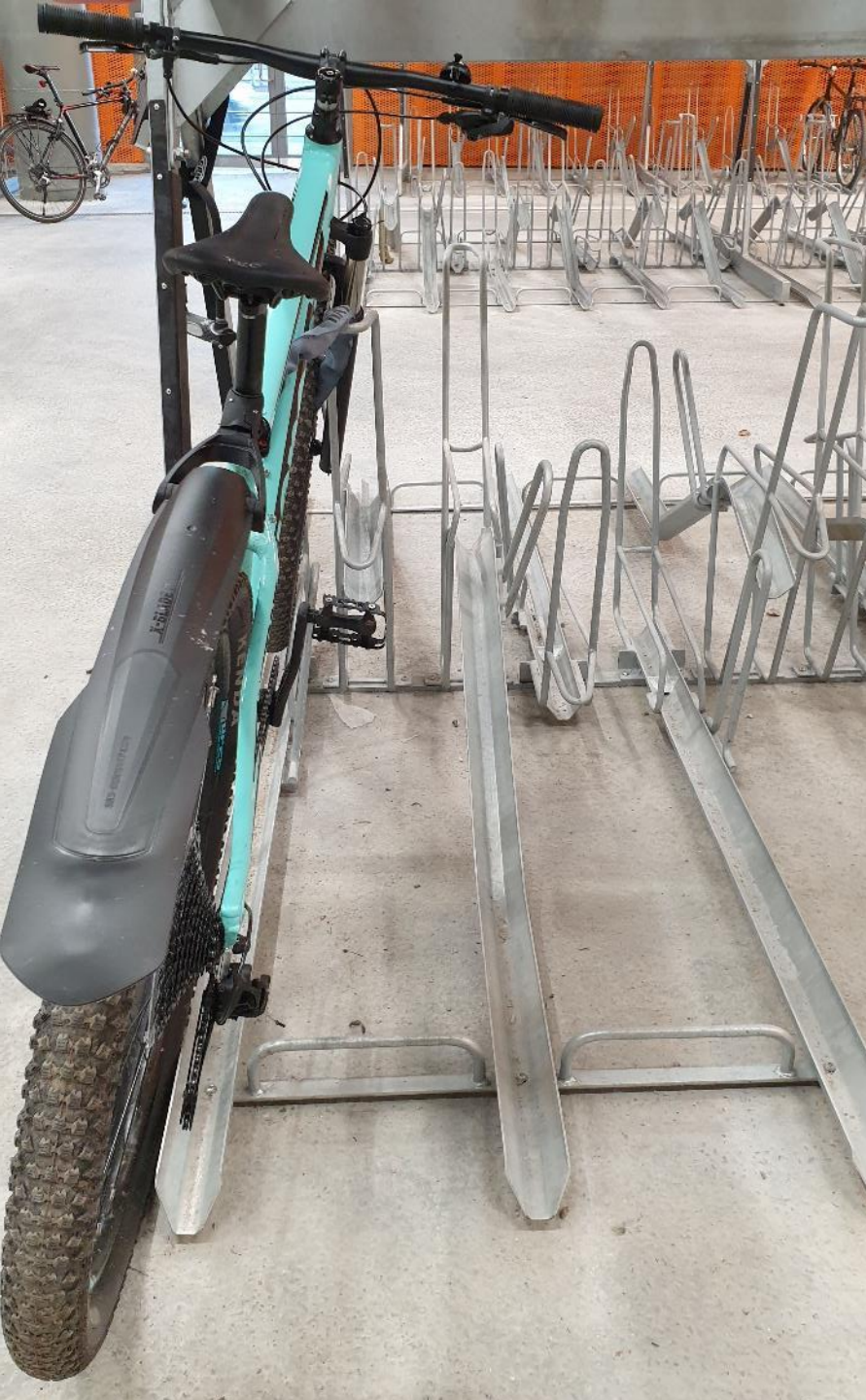
Kuva 21. Maastopyörän leveä rengas ei mahdu kaksikerrostelineen rengaskouruun ja leveä ohjaustanko "lukitsee" vieressä olevan pyörän telineeseen, jos telineväli on kapea.
