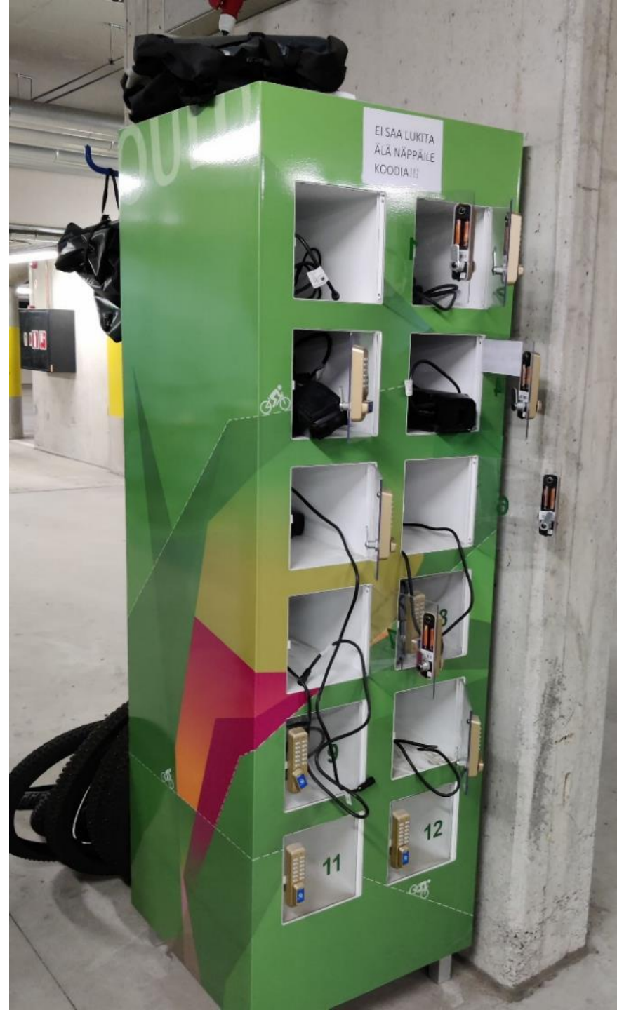
Kuva 28. Sähköpyörien akkujen latauskaappi Oulun ympäristötalolla (kuva Oulun kaupunki).
