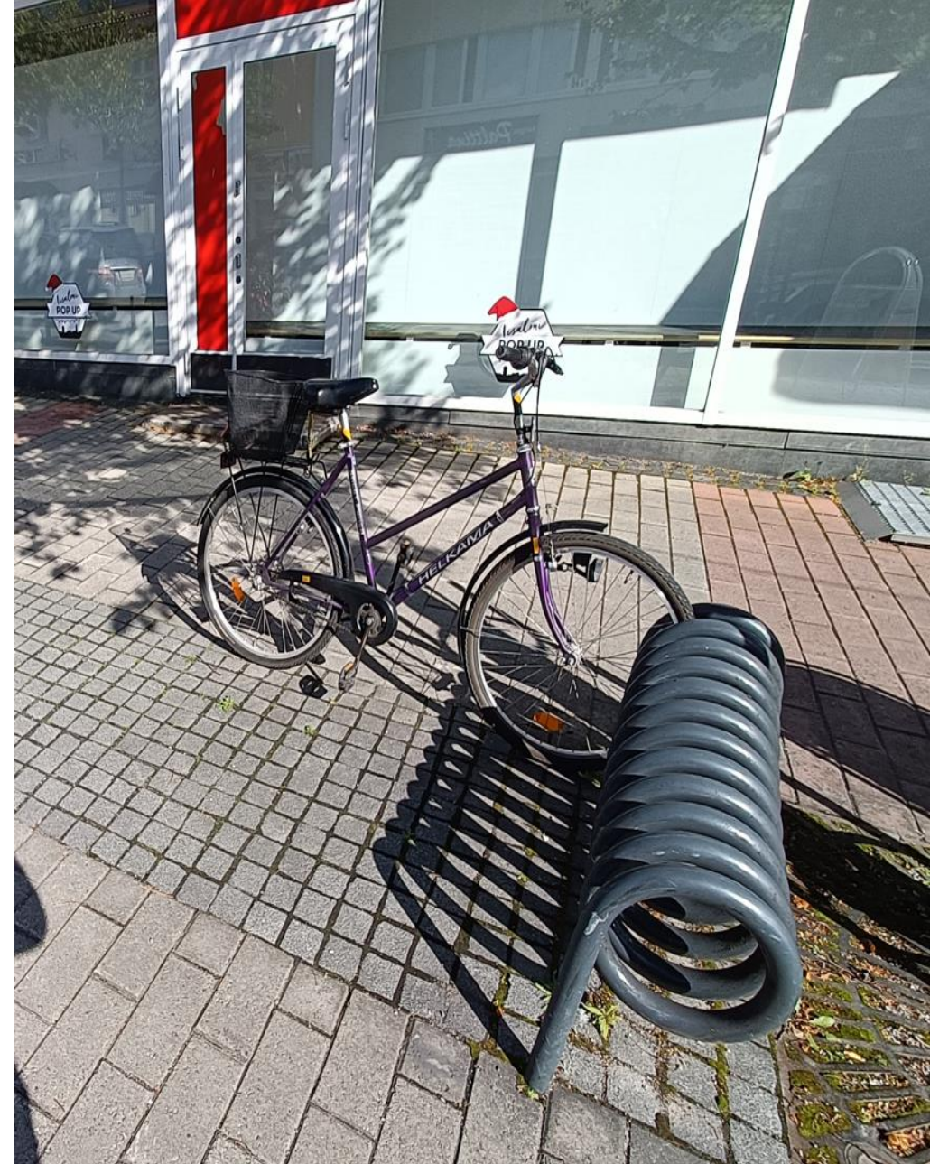
Kuva: Louhenkadun nykyisiä pyörätelineitä, joiden käytettävyyden on todettu olevan huono
