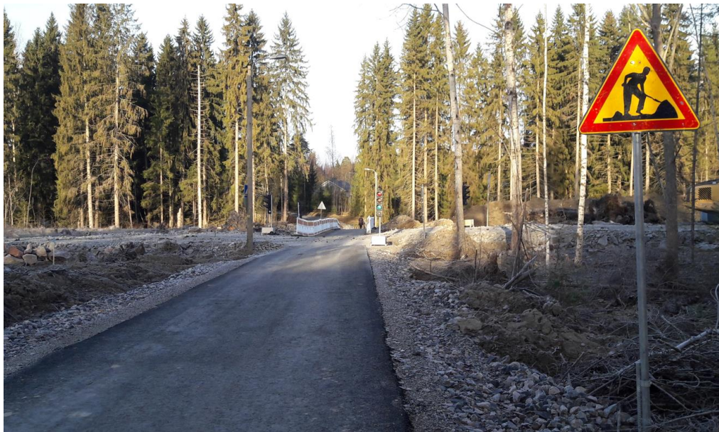
Liikennevalot työmaatien kohdalla^
