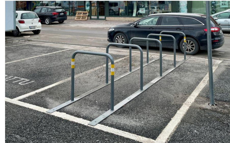
Leveä päällysteen päälle asennettu kaariteline Tampereella. Vähintään kolmen kaaren kokonaisuus voidaan asentaa päällysteen pinnalle yhtenä kappaleena.
