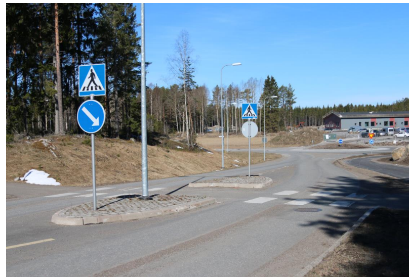
Myyräpolulla Hirvitien ylityskohdassa on keskisaareke.
