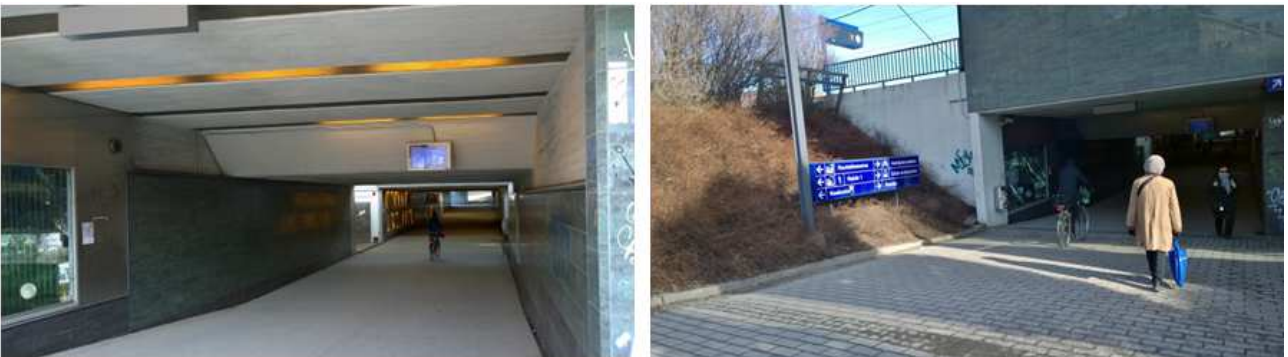
Kuva 11. Rautatieaseman ja linja-auto-aseman yhdistävä kävelylle ja pyöräilylle tarkoitettu alikulkutunneli. Alikulkutunneli kytkee yhteen Oulun keskustan ja Raksilan alueen. Alikulusta on ainoat yhteydet rautatielaitureille 2 ja 3. Alikulun yhteydessä tai välittömässä läheisyydessä rautatieaseman puolella ei ole tarjolla pyöräpysäköintiä.
