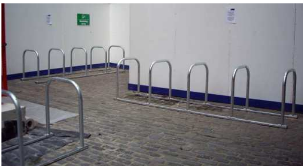
Kuva 8. Vasemmalla väliaikainen pyöräpysäköinti helposti liikuteltavilla runkolukitustelineillä ja oikealla kevyillä aidoilla järjestetty väliaikainen pyöräpysäköinti (Kuvan lähde: Transport for London ).
