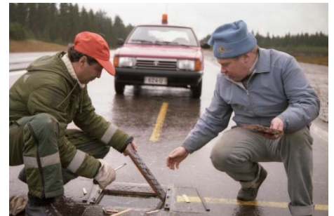
Kuva 1. Koekappaleiden asennus alustaan.
