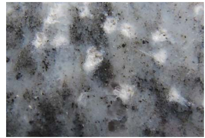
Nastan jälkiä kivilevyn pinnalla
