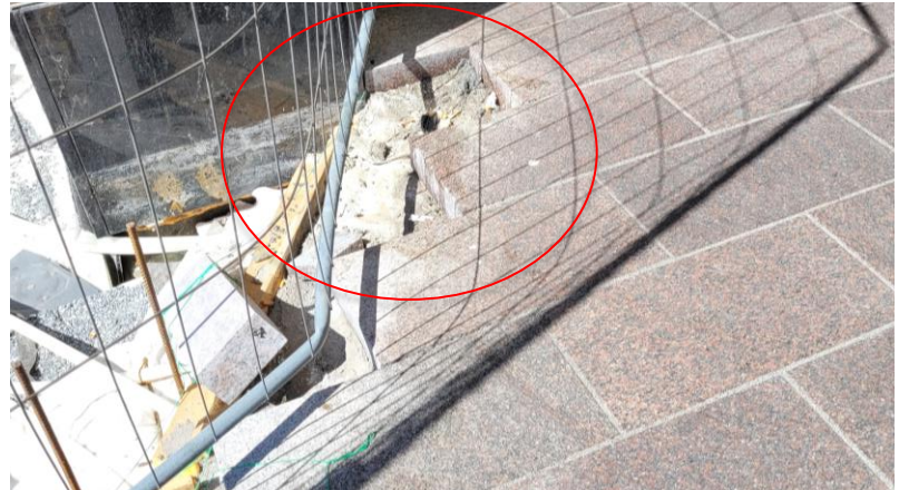
Kuva 2. Puuttuvat laatat kulkureitillä
