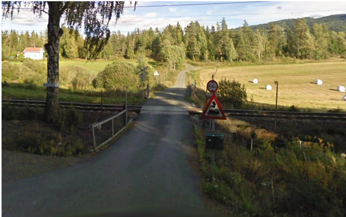
Kuva 4. Varoituslaitteeton, portilla varustettu tasoristeys Vikersundissa Norjassa. Kuvan lähde: https://goo.gl/maps/4v8gRgTT3W12
