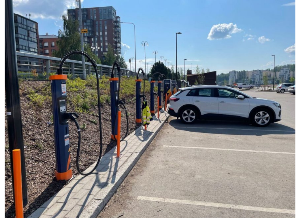
Kuva: Sähköautojen suurteholatausasema Jyväskylän satamassa.
